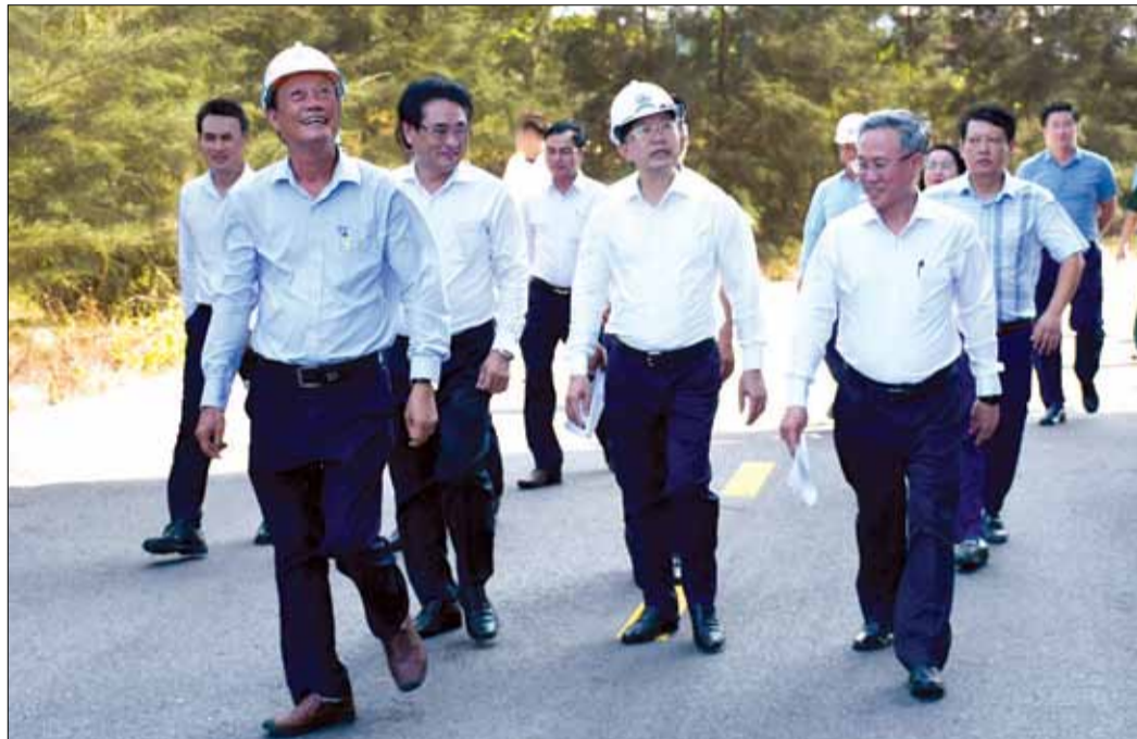
Bí thư Thành ủy Nguyễn Văn Quảng (giữa) kiểm tra tại dự án đầu tư xây dựng Công viên phần mềm số 2 giai đoạn 1. Ảnh: THÀNH LÂN
