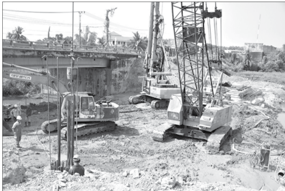
Thi công dự án cải tạo nâng cấp quốc lộ 14B, đoạn qua thành phố Đà Nẵng.
