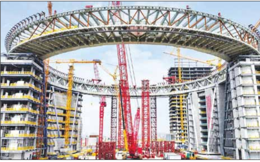
Công trình mang tính bước ngoặt trong tương lai tại Khu thương mại tự do Lingang của Thượng Hải, 'Ring of Lingang Glory', dự kiến sẽ đi vào hoạt động cuối năm 2024. Ảnh: VCG
