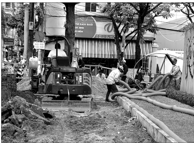
Các nhà thầu đang đẩy mạnh triển khai thi công dự án. Ảnh: THÀNH LÂN
