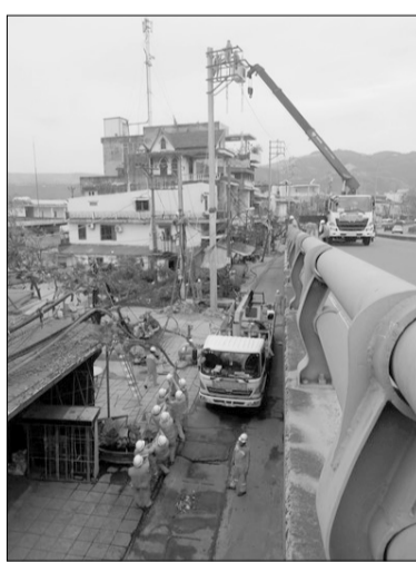
Không khí khẩn trương, nhiệt huyết trên từng tuyến đường dây.
