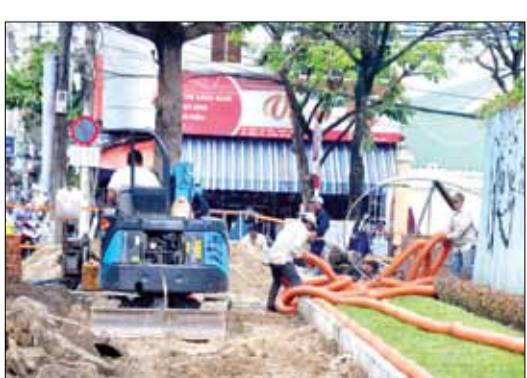
Các nhà thầu đang đẩy mạnh triển khai thi công dự án. Ảnh: THÀNH LÂN
