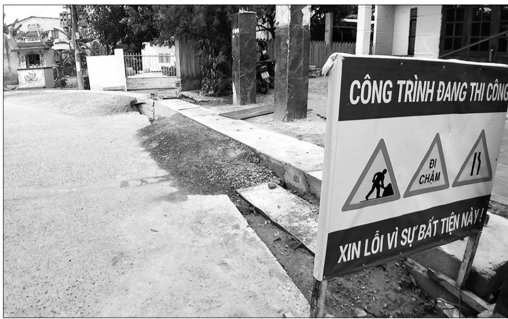
Dự án tuyến đường thôn Quá Giáng 2 nối tiếp tuyến đường Nhơn Thọ 1 ra đường Vành đai phía nam dự kiến hoàn thành trong tháng 10-2024.
