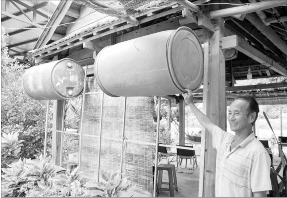
Ông Trương Sơn sáng chế bè chống lũ khi sử dụng 4 cái thùng phuy nhựa làm phao.
