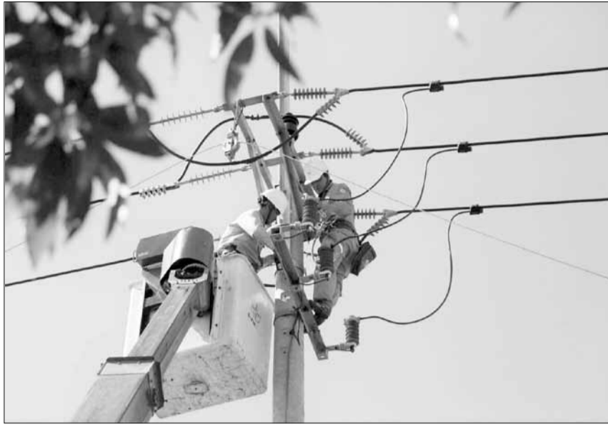
Giá điện tăng 4,8% từ ngày 11-10. TRONG ẢNH: Công nhân Công ty TNHH MTV Điện lực Đà Nẵng triển khai công tác bảo dưỡng lưới điện. Ảnh: PC Đà Nẵng
