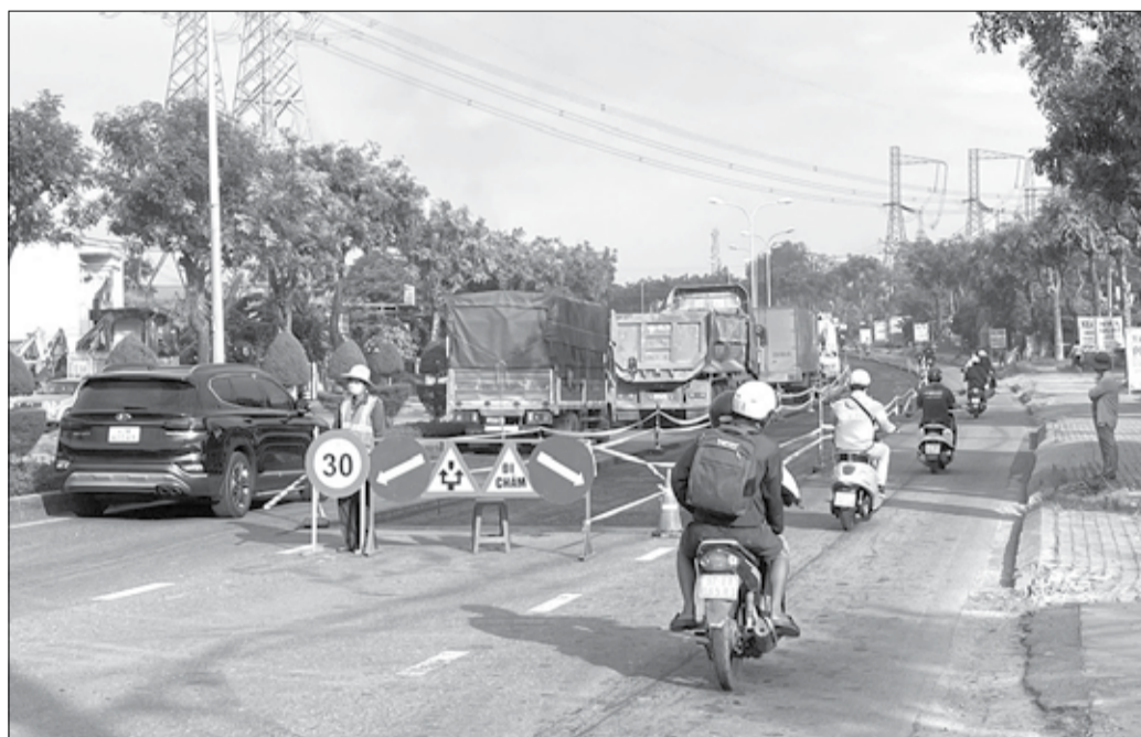
Lực lượng chức năng tiến hành sửa chữa tuyến quốc lộ 14B. Ảnh: THÀNH LÂN
