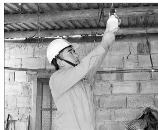
Sửa chữa, thay mới bóng đèn tiết kiệm điện hộ gia đình khó khăn.
