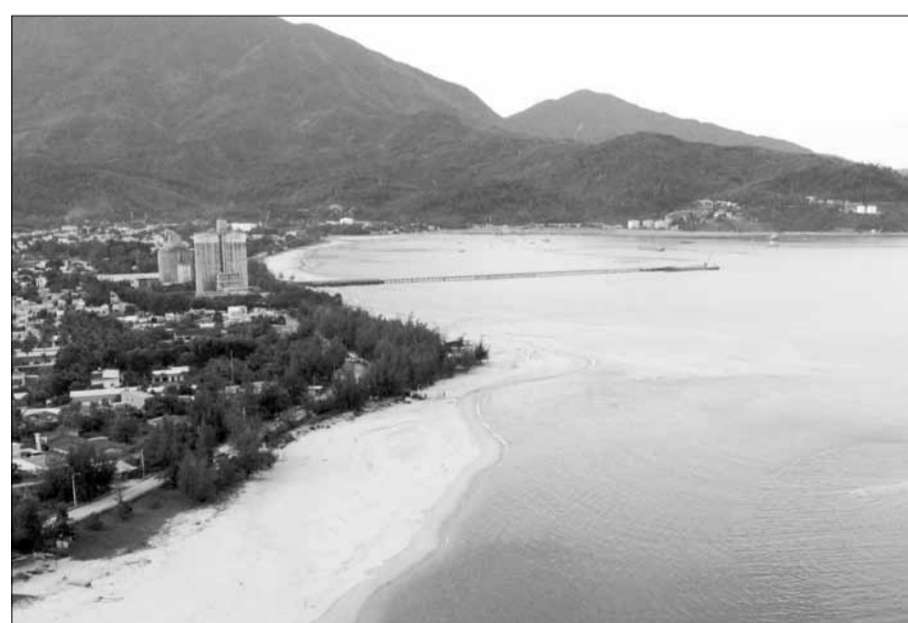
Khu vực phía sau cảng biển Liên Chiểu đang được quy hoạch để xây dựng trung tâm logistics cấp vùng, một khu chức năng của Khu thương mại tự do Đà Nẵng gắn với cảng biển Liên Chiểu.
