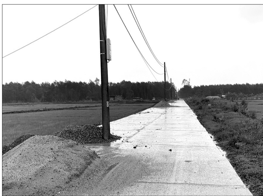
Trên tuyến đường giao thông nối từ thôn An Châu đi thôn Nam Thành có nhiều trụ điện chưa được di dời gây mất an toàn giao thông. Ảnh: PHƯỚC AN
