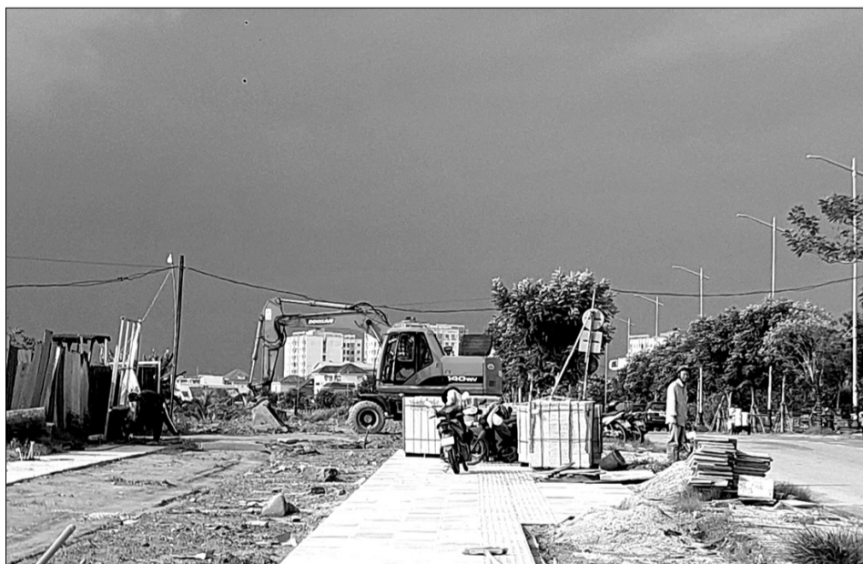
Các đơn vị thi công đang đẩy nhanh tiến độ để hoàn thành dự án Cải tạo cảnh quan vỉa hè, bờ sông đường Thăng Long (đoạn qua địa bàn quận Cẩm Lệ). Ảnh: TRỌNG HÙNG
