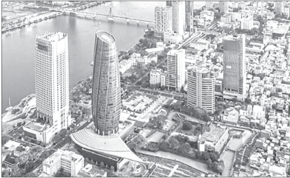
Quận Hải Châu đang nỗ lực hướng đến xây dựng đô thị hiện đại, văn minh, kiểu mẫu và trật tự đô thị. TRÔNG ANH: Một góc đô thị quận Hải Châu. Ảnh: PV
