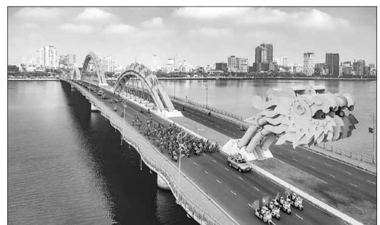
Cầu Rồng đóng vai trò quan trọng trong chiến lược phát triển và hoàn thiện hạ tầng giao thông đô thị thành phố.
